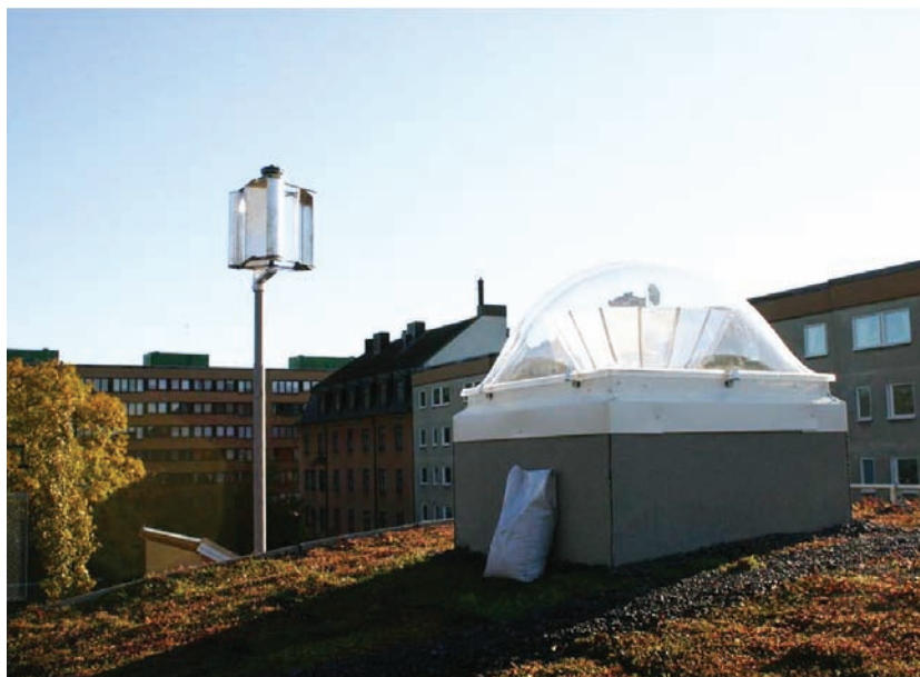
Grönt tak i Hornstull. LDT:s ljuskupol släpper in dagsljus till lokalen under. ▶
