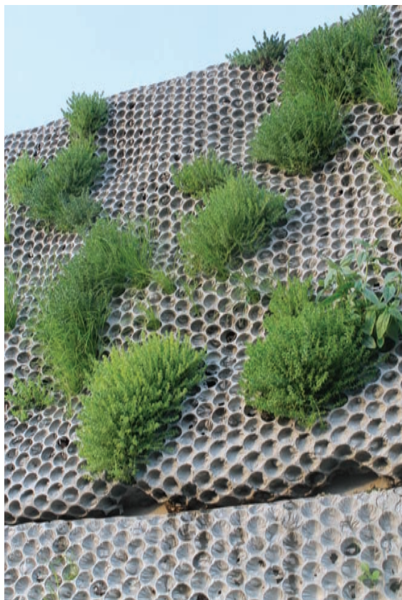
▲ Butong har skapat detta system av ihålig betong som både skapar ett externt byggnadsskal och en levande yta
