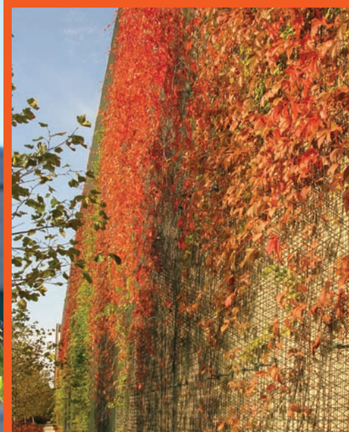
Green Screen är ett fasadtaäckande galler som specialanpassas för olika byggnader, växter och klimatzoner.
