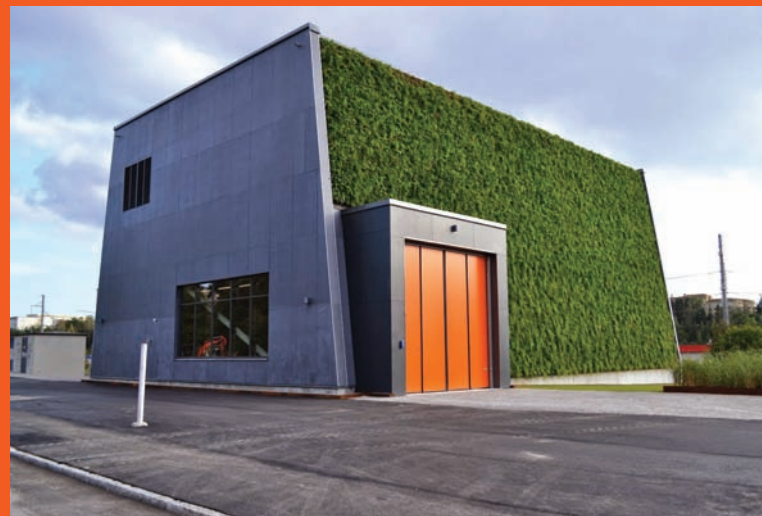
ANS-Global, Avfallscentral i Ursvik Sundbyberg Plastmoduler med integrerad bevattning
